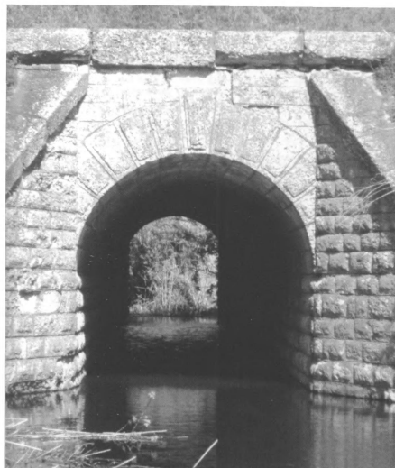
Водопропускная труба Балашовской ветки ЮВЖД (район с. Тимофеевка). Построена в 1901 г. Назначение то же. Фото 2012 г.
