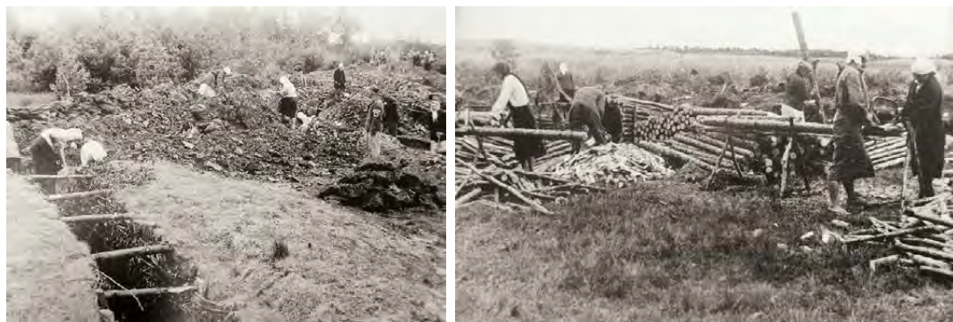
Женщины на строительстве оборонительной линии. Оперативный сектор немецкой 3-й танковой армии. За их работой наблюдает сотрудник немецкой военно-строительной организации. БССР, 1943–1944 годы
