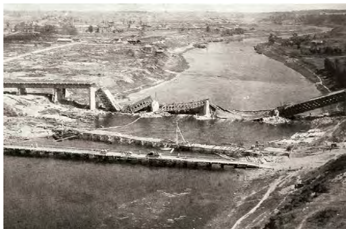
Взорванный немецкими войсками при отступлении мост через Днепр в Орше. 1944 год
