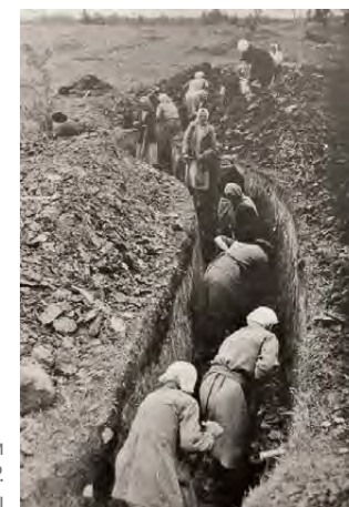
Женщины работают на немецкой оборонительной линии на оккупированной территории БССР. 1943–1944 годы
