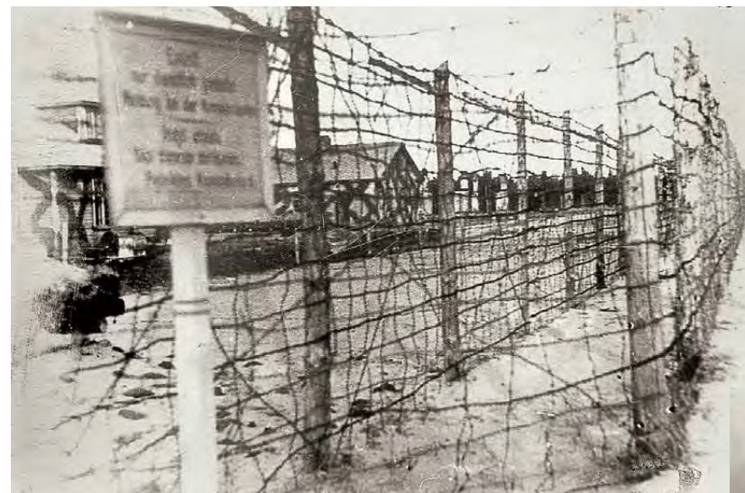
Проволочные ограждения перед территорией немецкого концлагеря Саласпилс в Латвии
