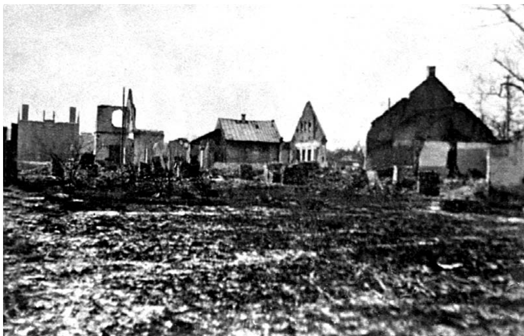
Разрушенные жилые дома по ул. 1 Мая в г. Бресте. 1941–1944 гг. БГАКФФД.
