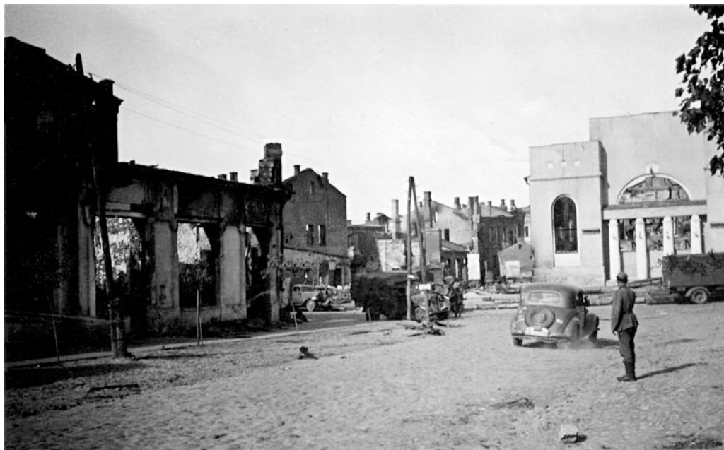
Гомель, улица Трудовая в годы немецкой оккупации. 27 августа 1941 г. На заднем плане – здание клуба швейников (бывшая Большая синагога). Из личной коллекции Ю.В. Панкова.
